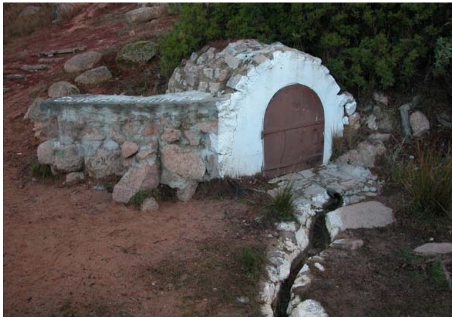
Fuente del Proveedor (R. Córdoba, diciembre 2004)
