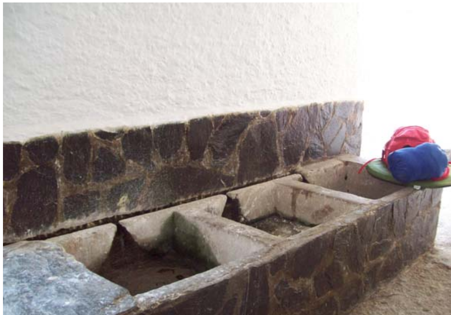
Lavadero municipal de Trevélez (Club Deportivo Nueva Aventura de Oria, junio 2010)
