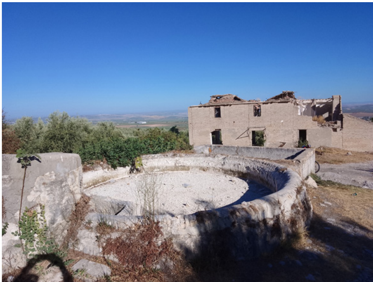
Fuente de los Soldados, vista interior y desagüe (F. Cuesta, septiembre 2020)
