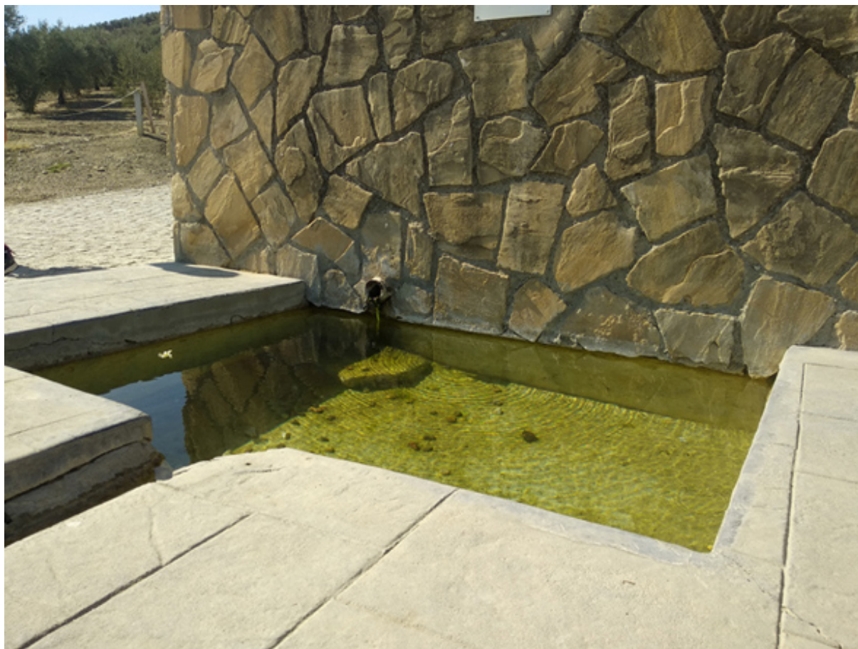
Fuente del Cortijo del Aljibe, vista de la pila pequeña y del caño (F. Cuesta López, noviembre 2021)
