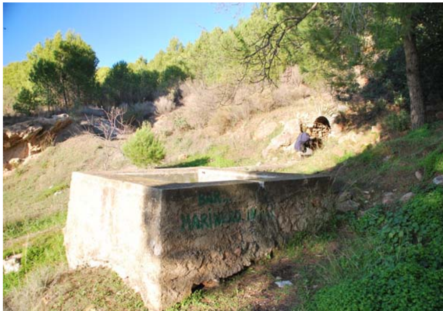
Alberca y entrada a la mina de agua (J. M. Fernández-Portal, enero 2010)
