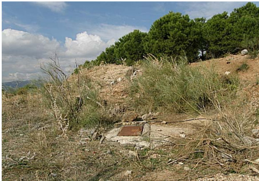
Depósito situado en el nacimiento (A. Vela Torres, octubre 2010)
