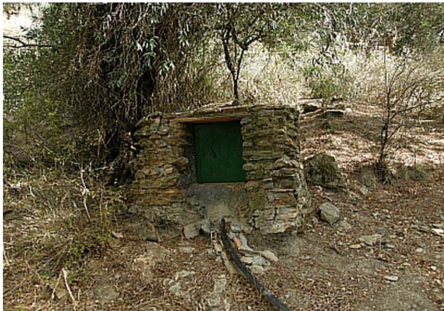
La mina se encuentra detrás de la arqueta (alcubilla), (M. Sánchez Pérez, noviembre 2010)
