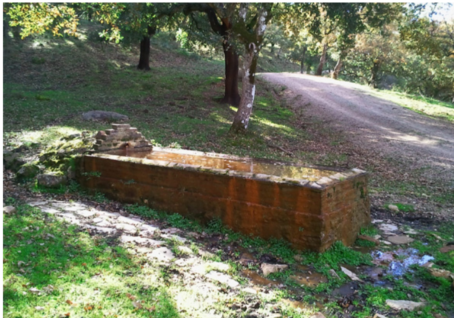
Pilar de la Solapa (D. Barrera, diciembre 2010)
