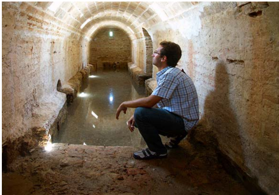
Galería subterránea principal del cuerpo de aljibes carolinos (Bóveda de medio punto de ladrillo macizo) (A. Galán Díaz, julio 2010)
