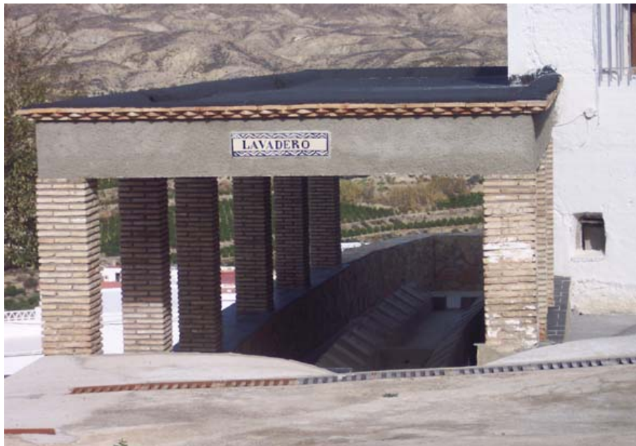
Lavadero reformado (panoramio-Google Earth, enero 2003)
