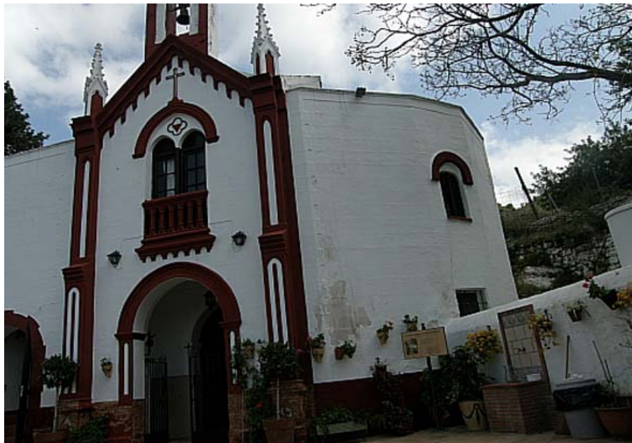
El manantial se encuentra en los cimientos de la Ermita (A. Vela Torres, marzo 2011)
