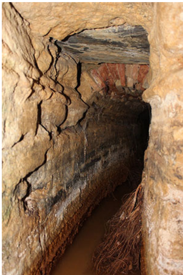
Detalle de la galería sur de Fuente Vieja (R. Rodríguez Pujazón, noviembre 2013)
