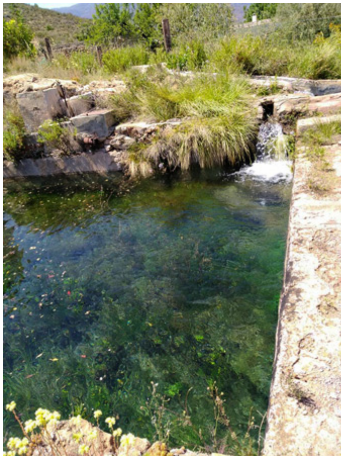
Entrada de agua en la balsa por acequia para su llenado (P. Sánchez, junio 2018)
