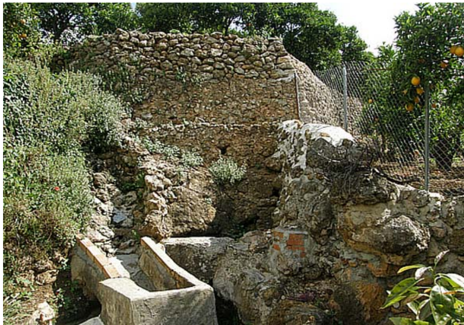
El manantial está en la base del muro de la imagen (A. Vela Torres, junio 2011)
