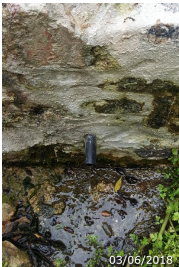
Salida de agua desde el pilar/abrevadero (A. Ventas, junio 2018)
