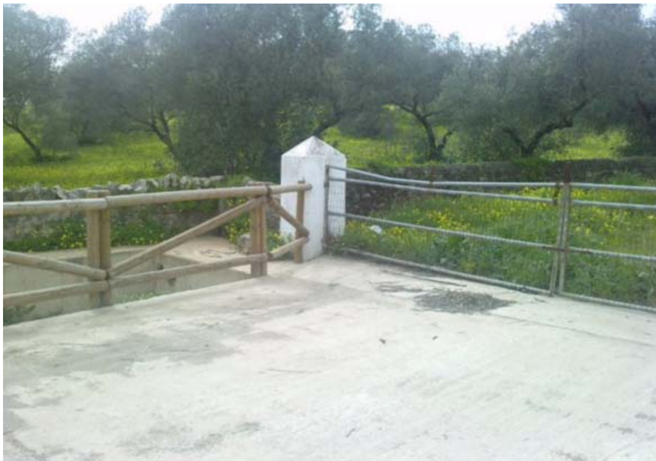
Acceso al manantial, cancela de entrada a la finca donde se ubica (Huelvapedía, Guadalinfo Vva Castillejos, marzo 2010)
