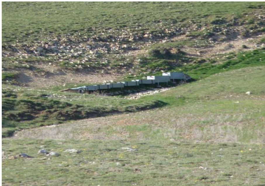
Tornaio de la Cañada de Huéscar (J. D. Cano Cavanillas, abril 2011)
