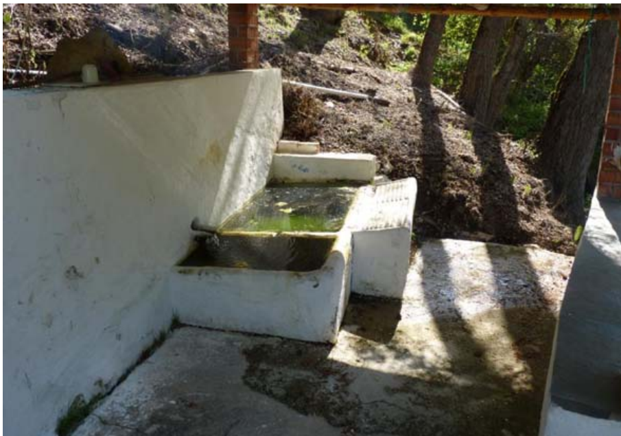
Lavadero del Romaguillo (J. D. Cano Cavanillas, abril 2011)
