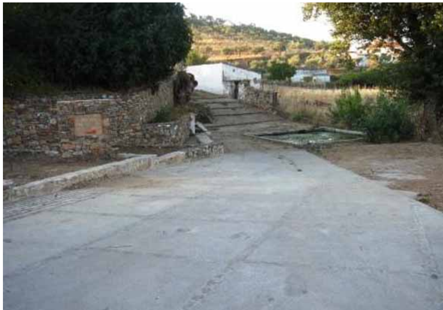
Acceso Norte al recinto de la Fuente de Las Pilitas (L. F. Espínola Guzmán, julio 2010)
