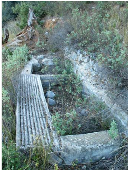
Fuente y lavadero de la Hoya del Puerco (L. Cano Cavanillas, noviembre 2007)
