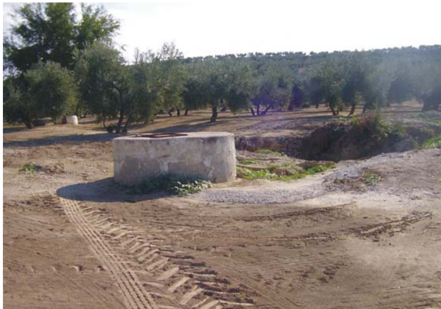
Fuente Agria Salobre, restauración con ladrillo, revestido de cemento y puerta metálica (M. Cala, octubre 2007)
