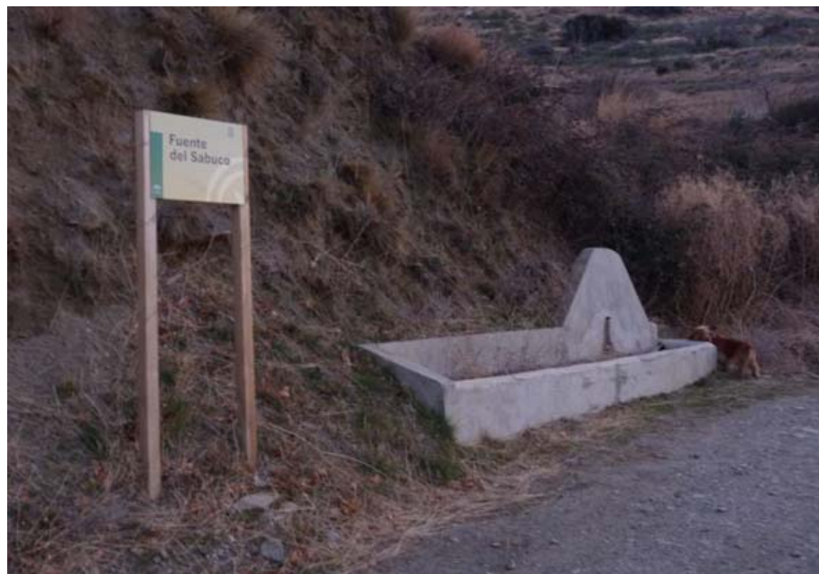
Fuente del Sabuco (L. Cano Cavanillas, diciembre 2011)
