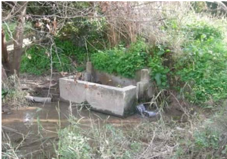
Detalle de la pequeña alberca de hormigón con las muescas para las compuertas (D. Cabello Moreno, enero 2012)
