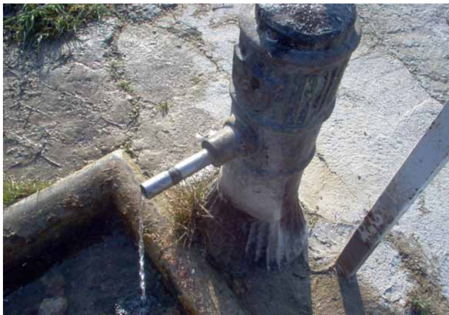
Fuente del Pilarillo (A. Civantos Moral, noviembre 2011)
