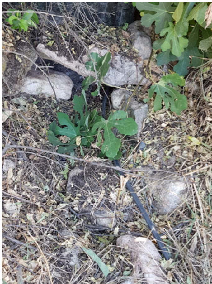
Tubo de riego saliendo bajo el suelo de la fuente, ladera abajo (A.Ventas, agosto 2020)
