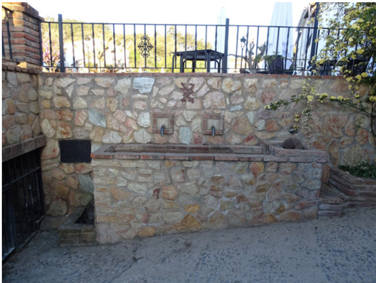
Vista de la nueva fuente restaurada recientemente (J. F. Martín Álvarez, abril 2023)
