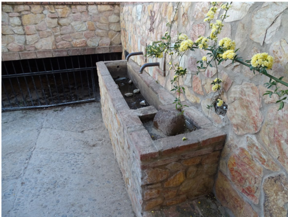
Vista de otra perspectiva de la nueva fuente restaurada recientemente (J. F. Martín Álvarez, abril 2023)
