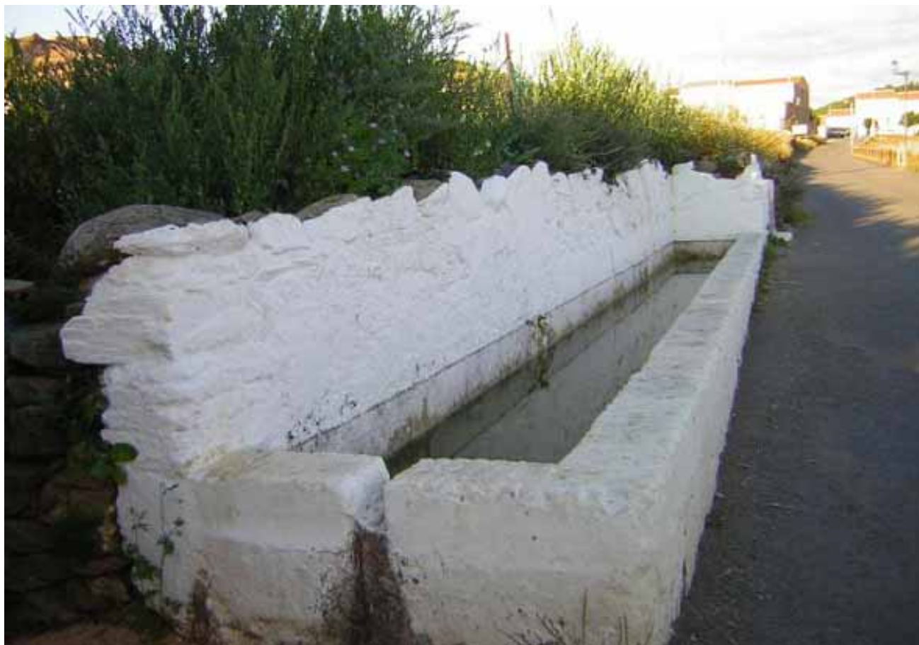
Pilar Nuevo (Huelvapedía-marijalmendro, agosto 2009)
