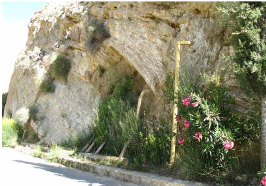
Drenajes de la Presa de Francisco Abellán (F. Sancho, junio 2012)
