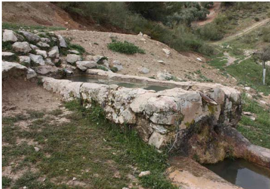
Pilón de Arcos (B.Montes, mayo 2012)
