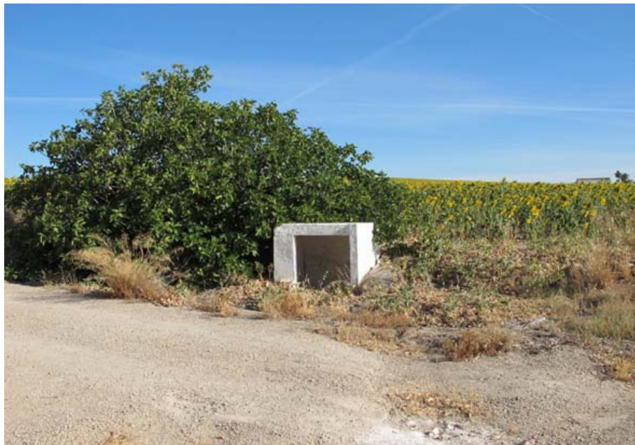
La Foronguilla, caseta de protección (M. Cerrillo, julio 2012)
