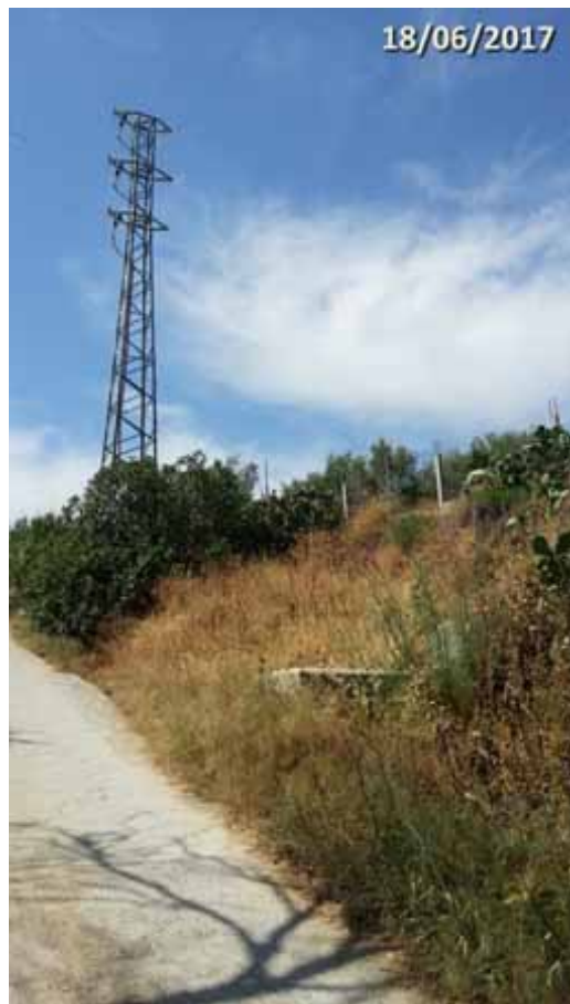
Vista inferior de la fuente, con el carril de acceso y la torreta de alta tensión en las cercanías (A. Ventas, junio 2017)
