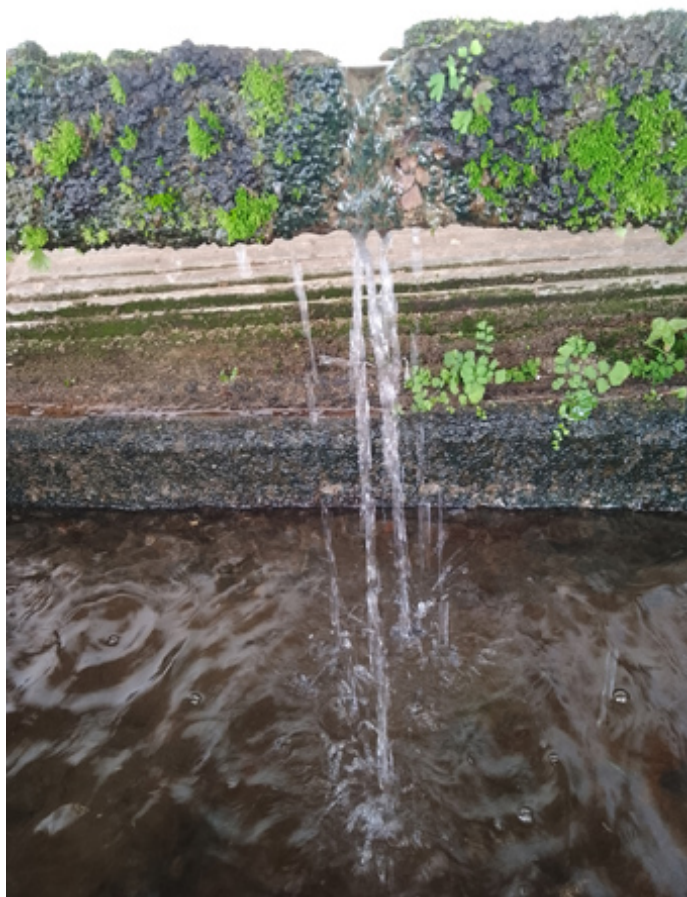
Detalle del distribuidor del lavadero (F. Cuesta López, octubre 2023)
