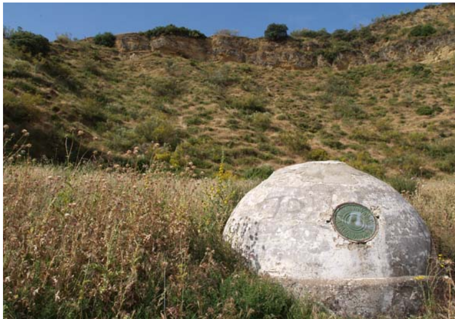
Arca de agua abovedada (A. Castillo, mayo 2006)
