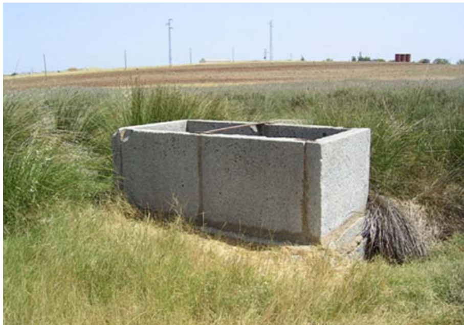
Pozo de los Caños (D. Gómez, agosto 2012)
