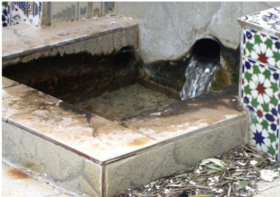
El caño principal de la Fuente de la Dehesa vierte sobre una pequeña alberca de obra. (D. Polo, febrero 2010)
