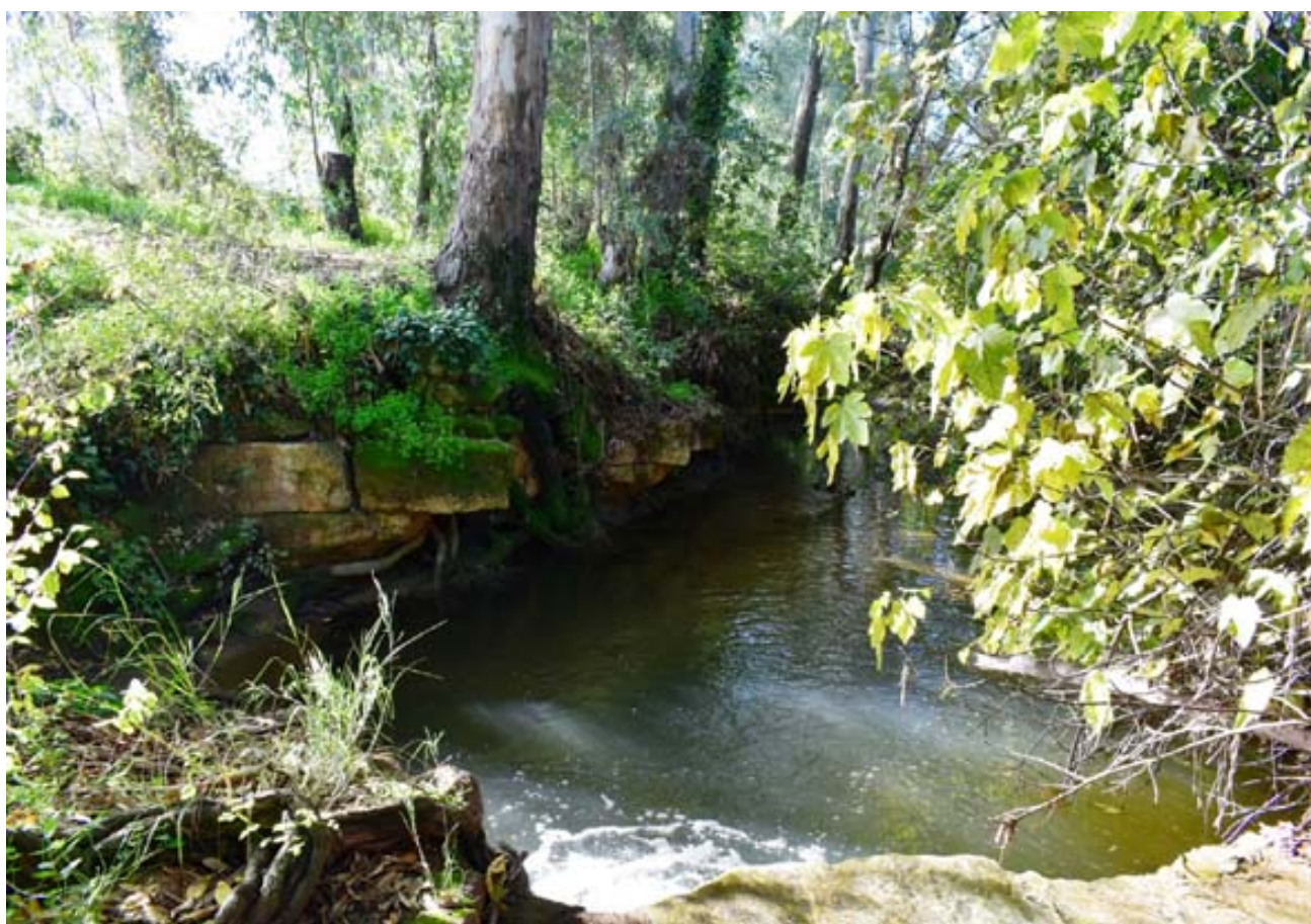
Depósito de agua romano conformado por hiladas de sillares; emplazamiento en medio del cauce del arroyo del Toril (A. Márquez Pascual, diciembre 2018)
