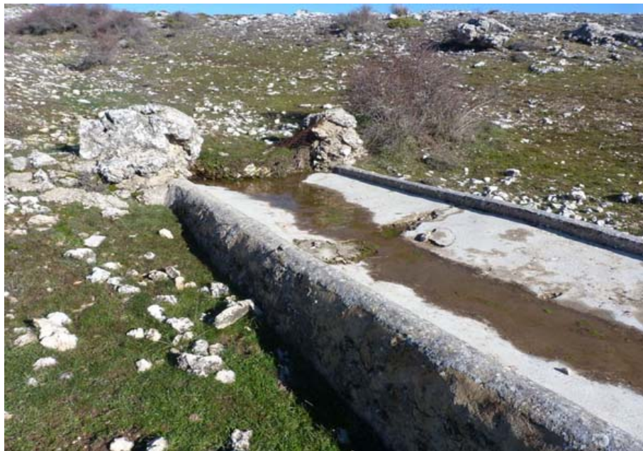
Pozo de Purga (L. Cano Cavanillas, diciembre 2012)
