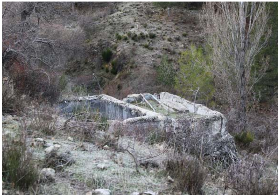
Fuente en el Arroyo de Artuñado (L. Cano Cavanillas, diciembre 2013)
