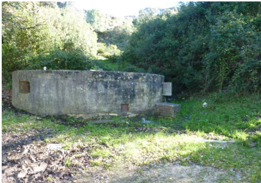
Pozo de captación (M. Cabello, marzo 2013)
