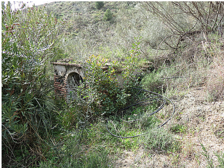
Mina tercera del Camino de la Encina (A. Vela Torres, diciembre 2012)
