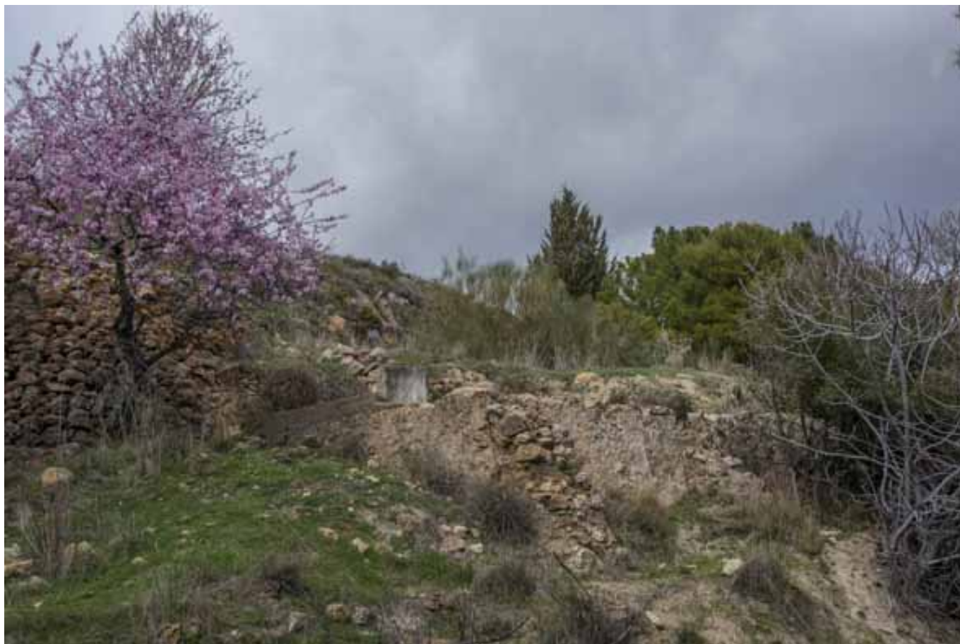
Muro de contención de la antigua balsa (J. Rubia González, febrero 2020)
