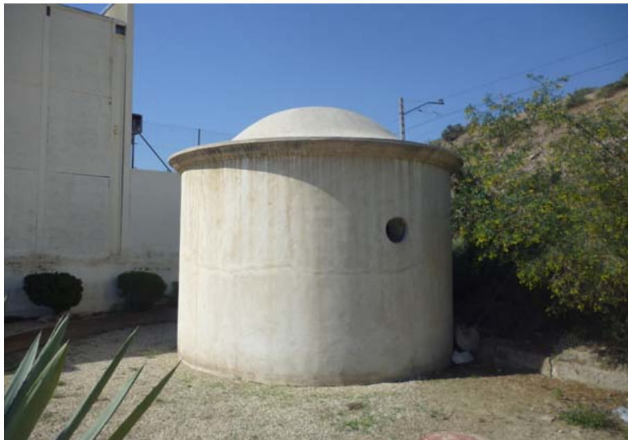
Bóveda de media naranja de cal y canto, rehabilitada en el 2005 (E. Milla, mayo 2013)
