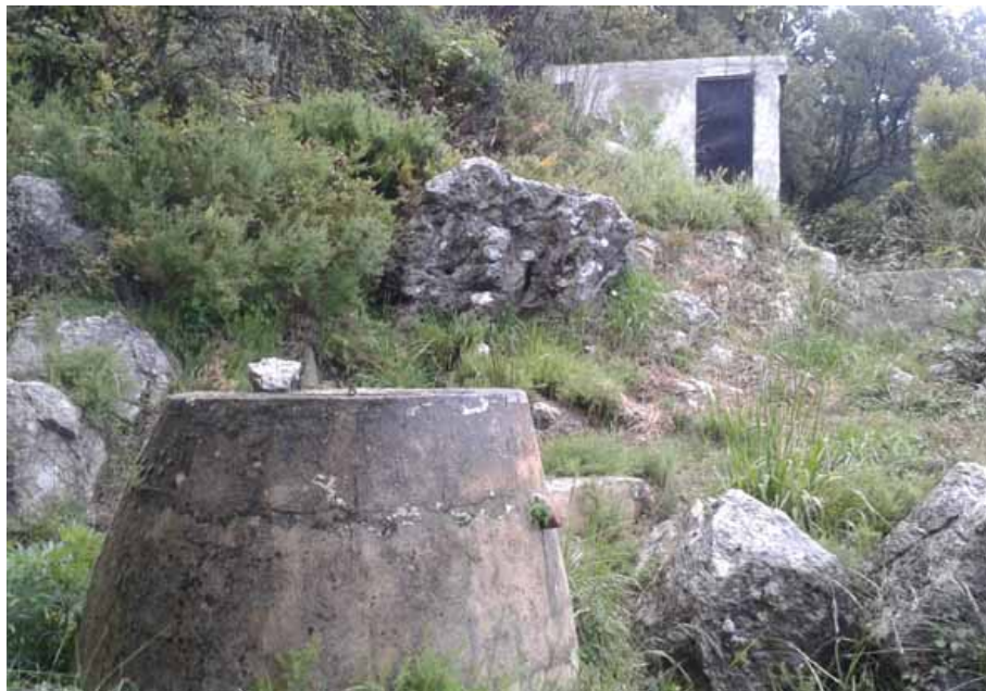
Caseta de captación del agua en el manantial. En primer plano, registro de conducción (J. M. Fernández-Palacios, mayo 2013)
