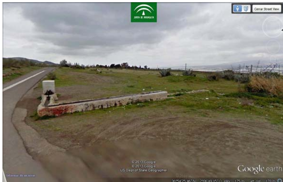
Fuente del Escribano (Google earth-Street View)
