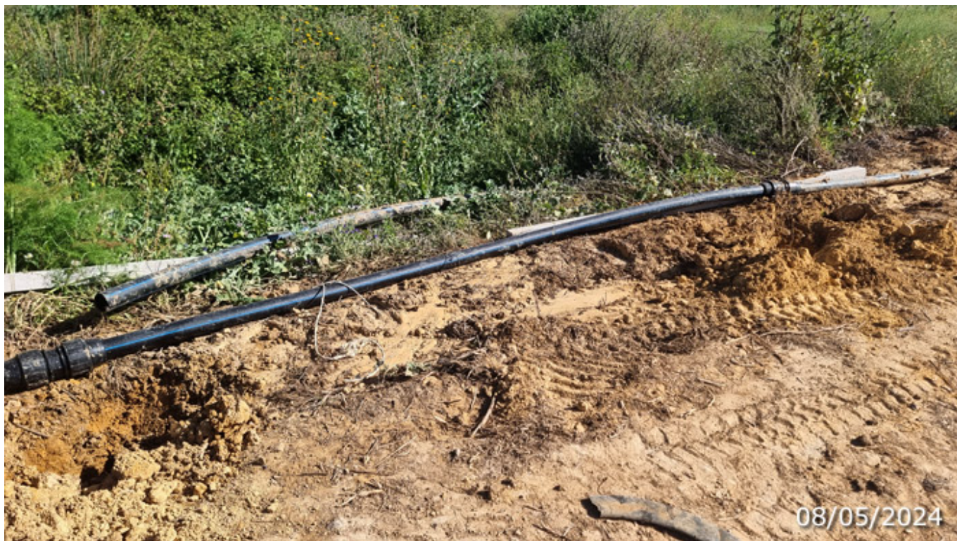
Conducción de polietileno desde la Fuente del Mal Nombre, a la vista tras unos trabajos en el camino (A. Ventas, mayo 2024)
