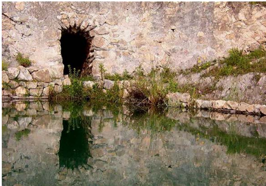
Fuente de la Maciguilla, galería (E. Porcel, 2004)
