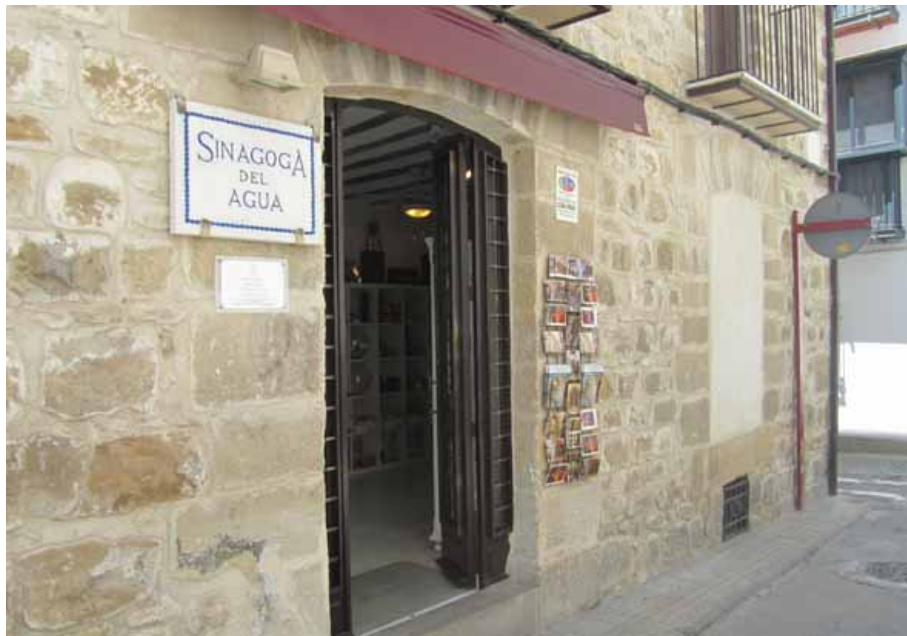
Entrada del edificio (L. Linares, julio 2013)
