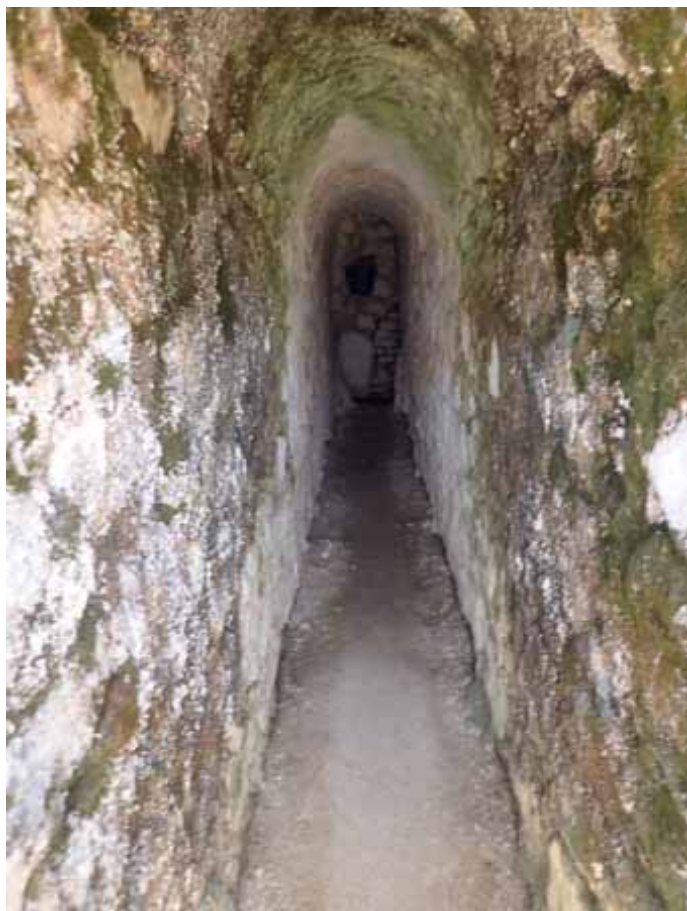
Interior de la galería (T. Peinado Parra, agosto 2017)
