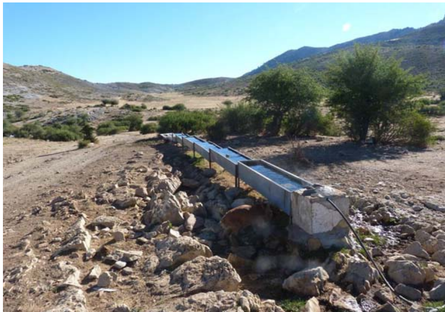
Tornajos de la Tinada de Puerto Lezar (L. Cano Cavanillas, agosto 2013)
