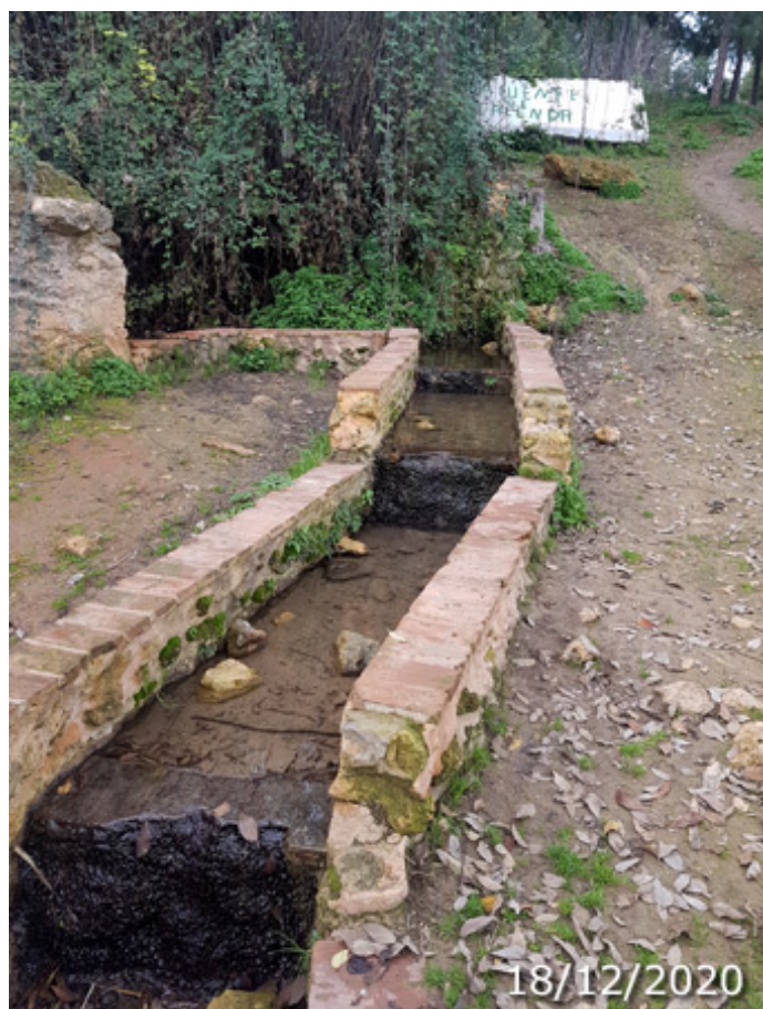
Conducción abierta de las aguas del manantial y el aljibe unidas (A. Ventas, diciembre 2020)
